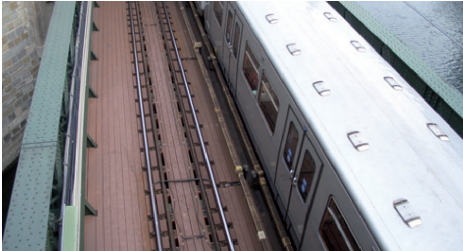
Abb. 3: FFU Kunstholz, Zollamtsbrücke der Wiener Linien
