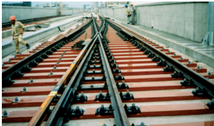
Abb. 8: FFU Kunstholz, Weiche auf Fester Fahrbahn, Japan
