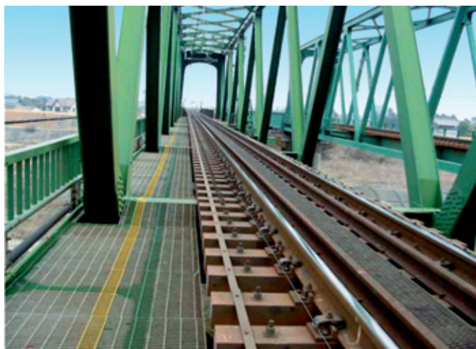
Abb. 9: FFU Kunstholz als Brückenholz auf offenem Stahltragwerk, Japan Bilder: 7-9: Sekisui
