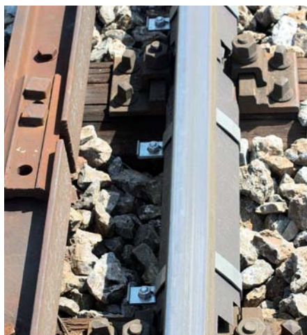
Abb. 10: System Sekisui nach Umbau
