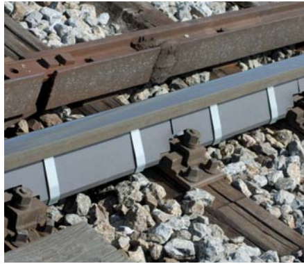
Abb. 4: System Sekisui (Dämmwand)
