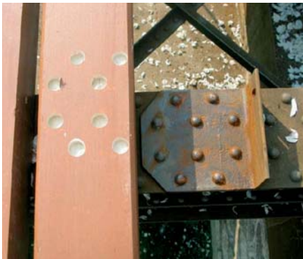
Abb. 6: Bohrschema für Nietausnehmungen
