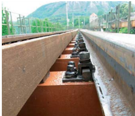
Abb. 7: Endzustand nach Einbau der FFU-Hölzer
