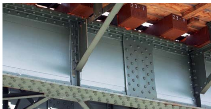
Abb. 12: Trägerstegbedämpfung Calmmoon
