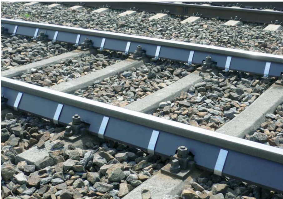
Abb. 6: CalmRail in Schotterfahrbahn Deutsch-Wagram
