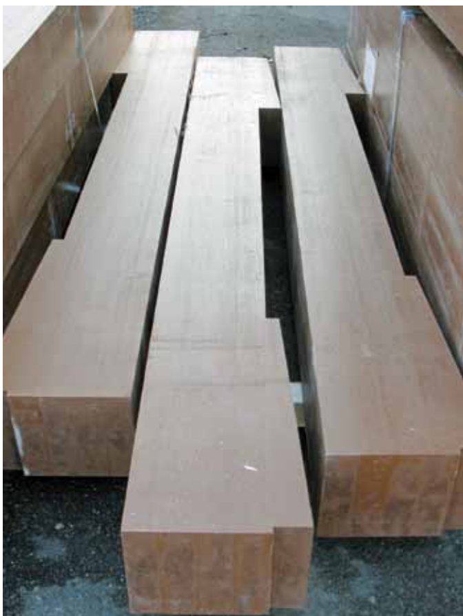
Abb. 4: Ostbahnbrücke ÖBB Wien, Überhöhung an Brückenhölzern ab Werk Foto: G. Koller
