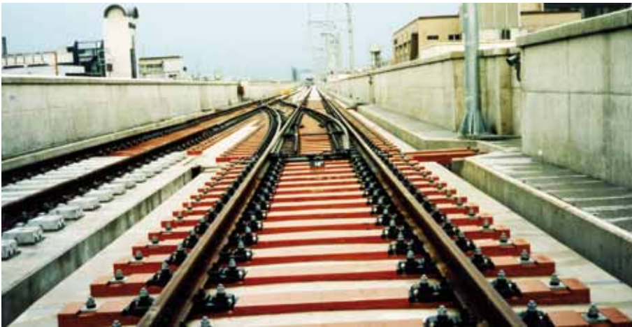
Abb. 8: Weiche auf FFU Kunstholz in Fester Fahrbahn (Japan)
