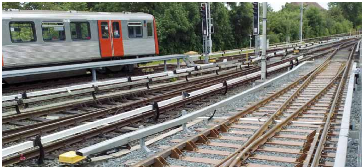
Abb. 1: Weiche der Hamburger Hochbahn im Betriebsbahnhof Farmsen
