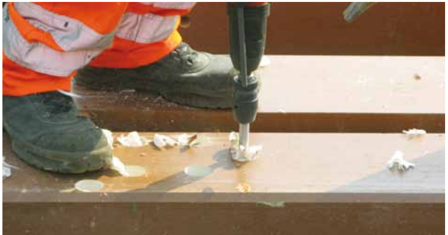
Abb. 5: Bohrung der Ausnehmung für den Nietenkopf (ÖBB Hainburg)
