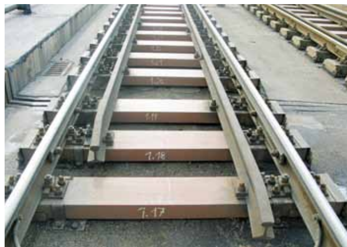
Abb. 3: Direkte Befestigung mit FFU Kunstholzschnellen H = 10 cm (Wien)
