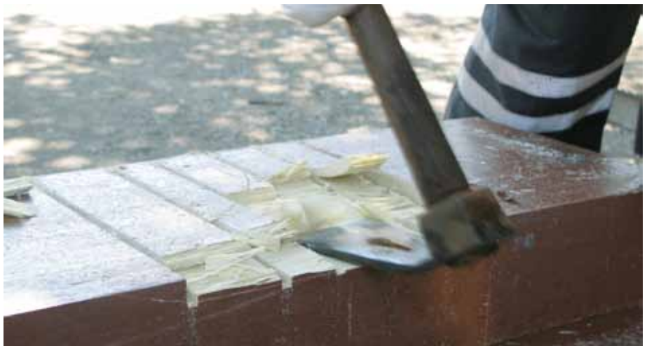
Abb. 6: Ausstemmen des Auflagerbereichs, Brücke über die Save (Belgrad)
